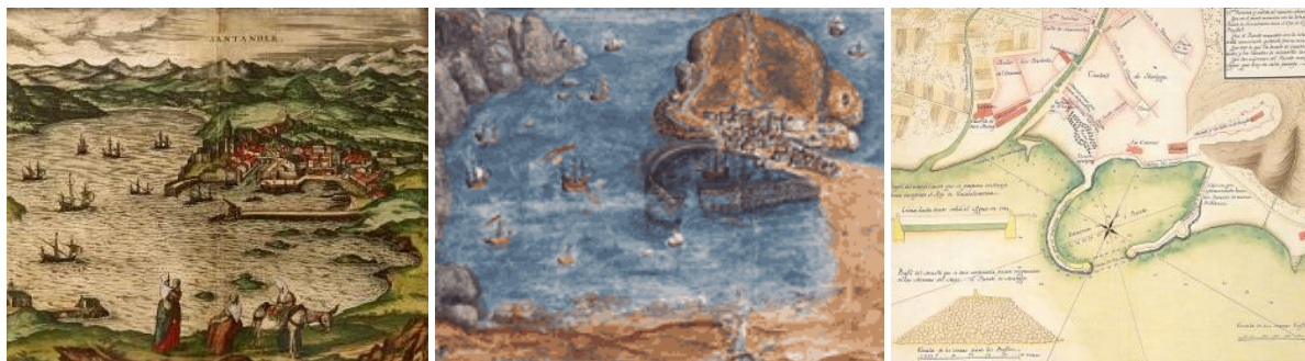
Figura 1. Diques de los puertos de Santander (1575), Gijón (1635) y Málaga (1720).
