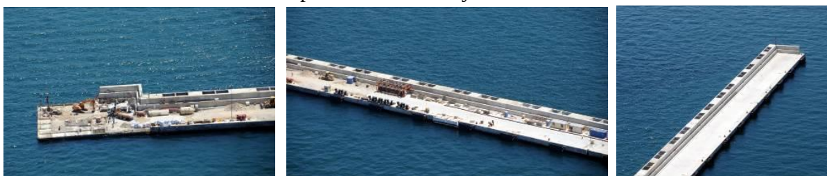
Figura 27. Etapas constructivas y obra finalizada.
