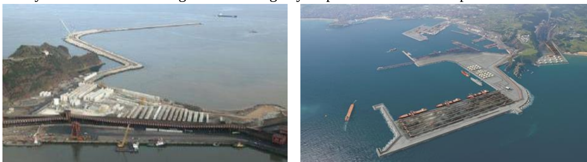
Figura 8. Ampliación en ejecución y finalizada, con el puerto antiguo al fondo.
