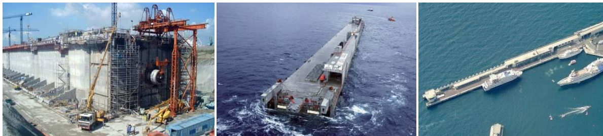
Dique seco. Puerto Algeciras (España)
