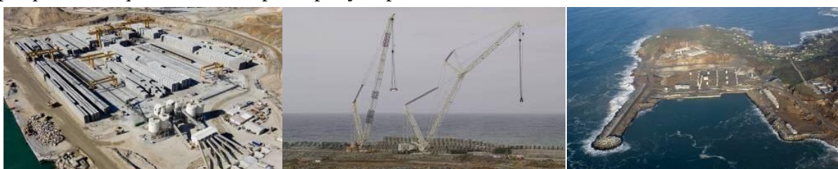
Figura 22. Parque de bloques principal y puerto auxiliar.
