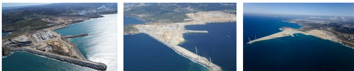
Figura 23. Estado de las obras. Final campaña 2007, julio 2008 y mayo 2009.
