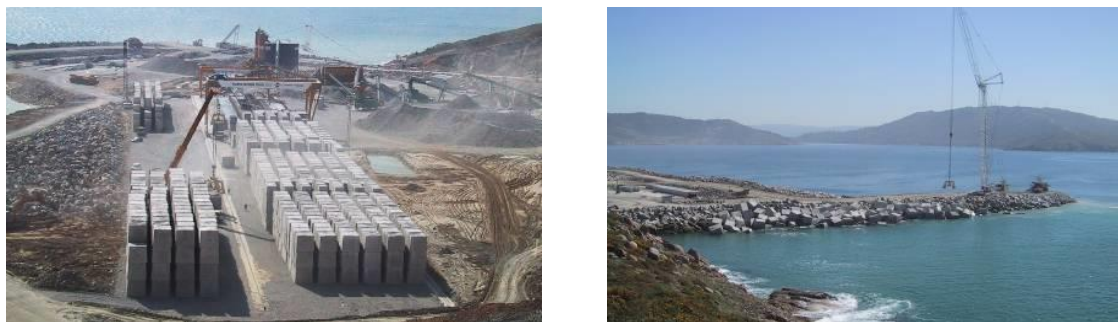
Figura 17. Parque de fabricación de bloques. Grúa de colocación y ejecución del espaldón.
