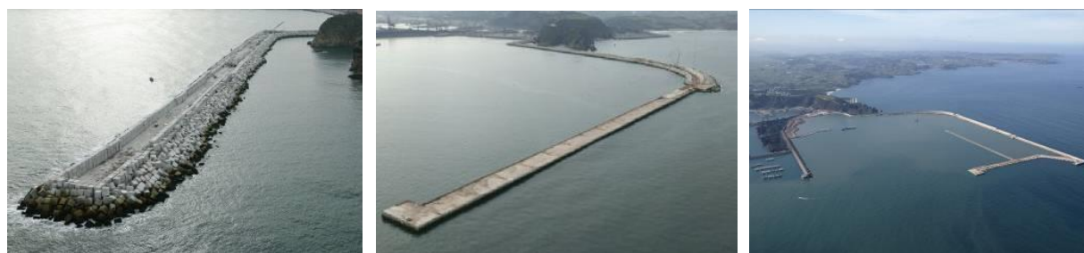
Figura 14. Estado de las obras. Veranos 2006, 2007 y 2008.
