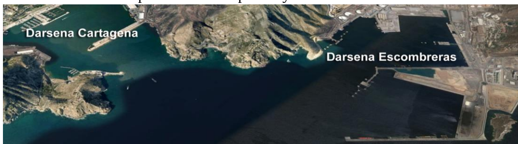
Figura 27. Panorámica del puerto de Cartagena. Dársenas Cartagena y Escombreras. El dique consta de 4 tramos con profundidad máxima de 52 m. Sus características son:
