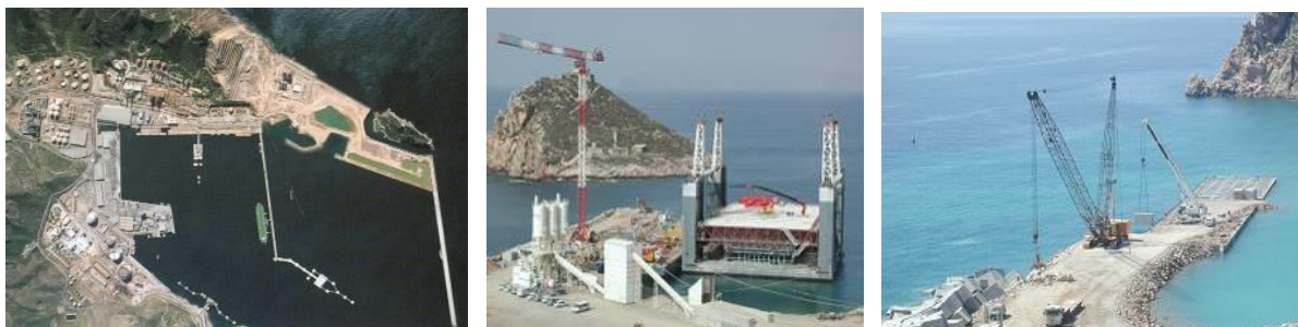
Figura 30. Obra finalizada y Etapas constructivas: cajonero y colocación de bloques.
